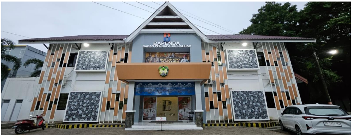
Keterangan: Kondisi Bangunan Gedung Badan Pendapatan Daerah setelah renovasi (Desember 2023)
